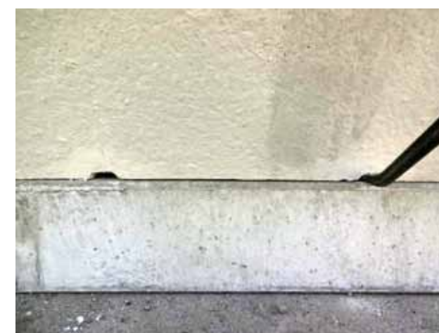
施工用 バール差込用切り欠け
