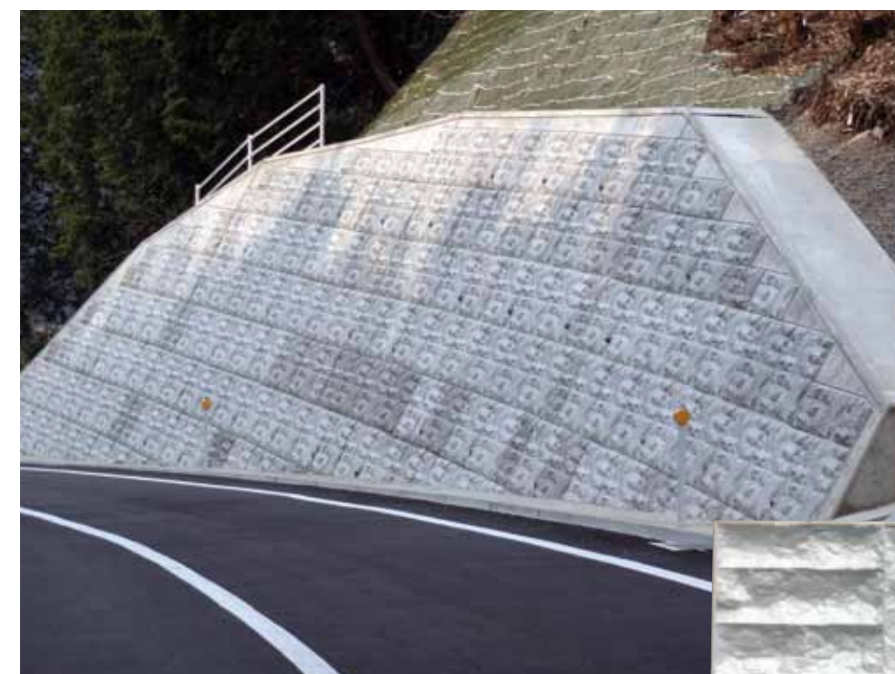
製品と同じ模様の発泡スチロール型枠を用意しております。
